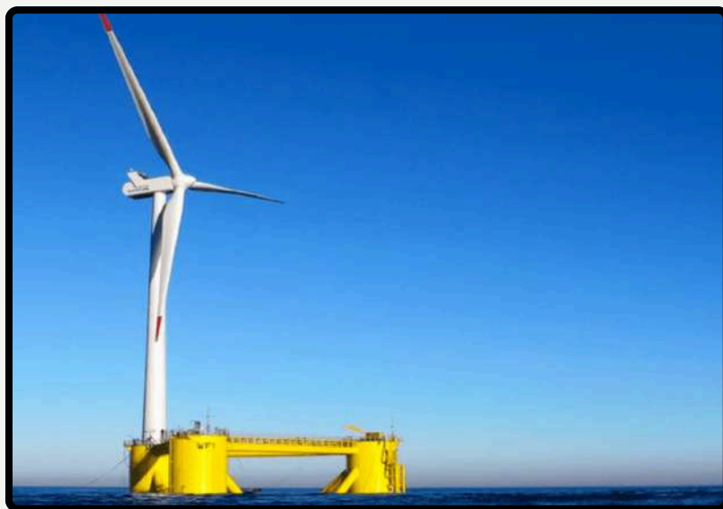
Photographie d'une éolienne offshore au large de Leucate
