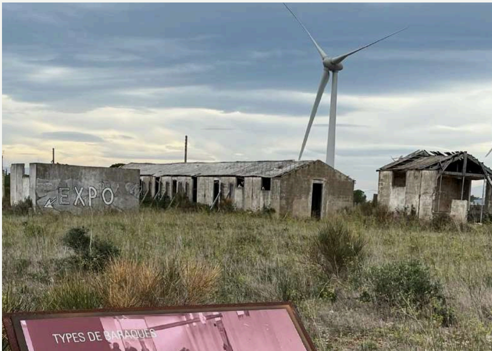
Baraques délabrées du mémorial de Rivesaltes (photo prise le 19/10/2023)
